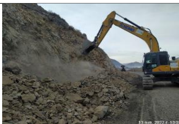
Фото 2. Экскавация скальных пород на км42+420 - км42+480 LS.
