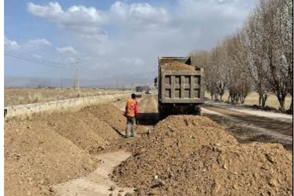
Фото 12. Засыпка саббейс км66+740-км67+740 RS.
