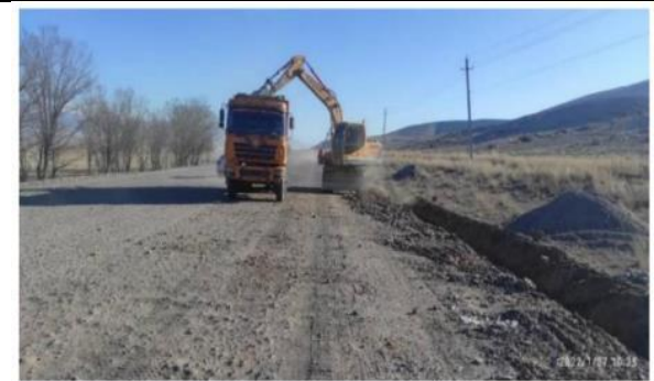
Фото 18. Эكскавация канав на км 85+420.
