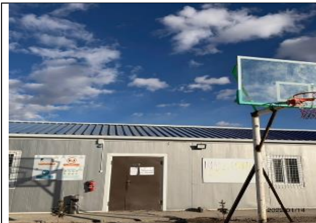
Фото 43. Лот 2 Баскетбольная площадка.
