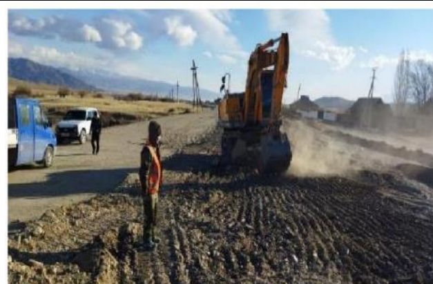
Фото 19. Кирковка существующего дорожного покрытия на км 88+660 - км 88+750.
