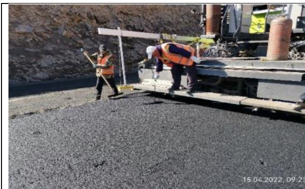
Фото 13. Укладка биндер слоя на км 17+230 - км 17+500.
