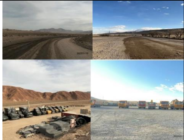
Фото 54. Сверху: Пылеподавление Лот 1 и Лот 2 Снизу: Стоянки в надлежащем состоянии Лот 1 и Лот 2.
