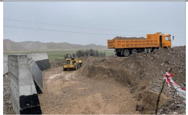
Фото 22. Обратная засыпка моста км 88+795.
