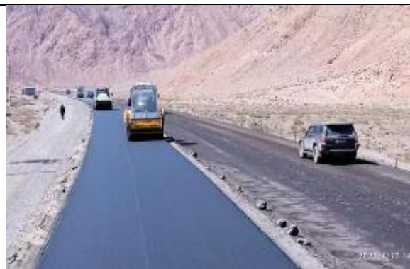
Фото 14. Уплотнение биндера на Km15+600-km16+440 RS.
