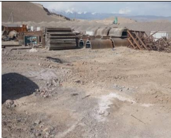
Фото 71. Разбросанные обрезки материалов были убраны, а площадка очищена.
