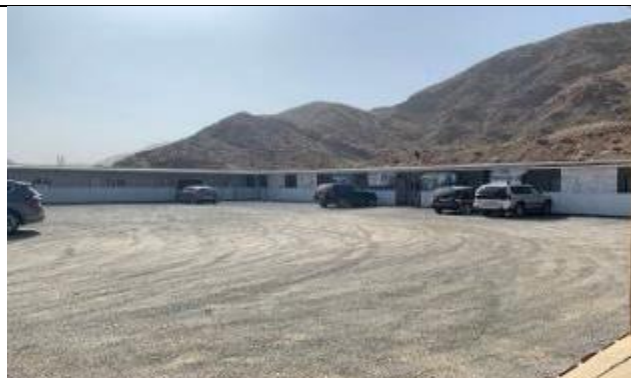
Фото 30. Лот 1 лагерь и стоянка на км 16 + 100 (RS).
