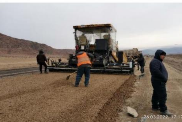
Фото 11. Устройство слой бейс км 16+300 - км 19+000.
