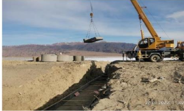
Фото 7. Установка ЖБТ на км35+469.
