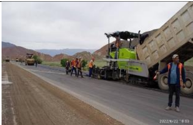
Фото 25. Укладка биндер слоя км 17+564 - 18+677.
