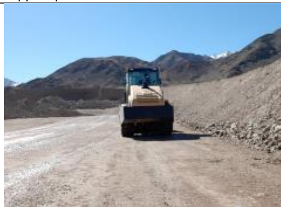
Фото 62 Укладка и укатка слоя глины перед отвалом удаленного асфальта.
