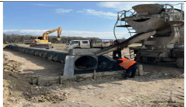
Фото 27. Строительство кульверта км 62+700.
