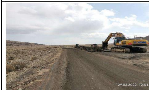
Фото 3. Окировка существующего асфальта на км31+000.
