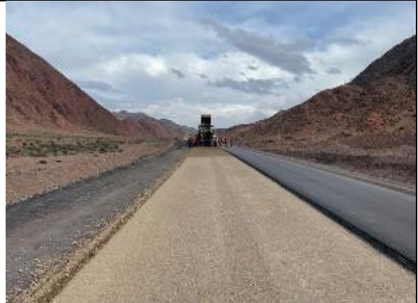
Фото 10. Укладка щебня на км км14+600-15+000 (LS).
