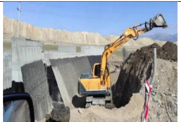
Фото 26. Обратная засыпка фундамента и опор моста через р. Жаркурумду км 88+795.
