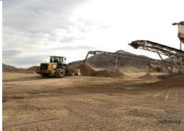
Фото 51. КДУ в работе Лот 1.
