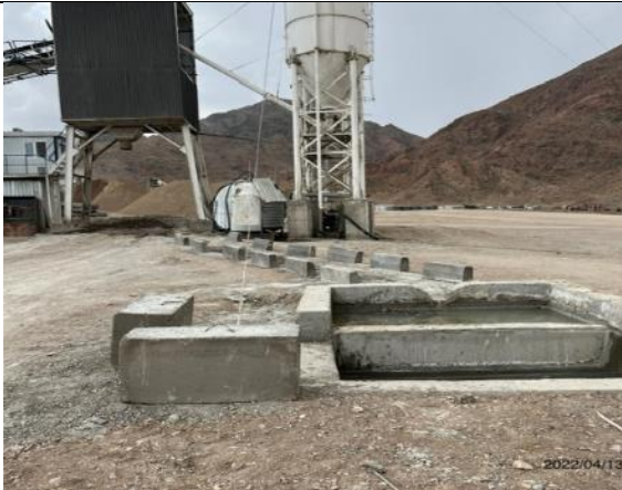
Фото 67. Для БСУ предусмотрен 3-камерный отстойник.
