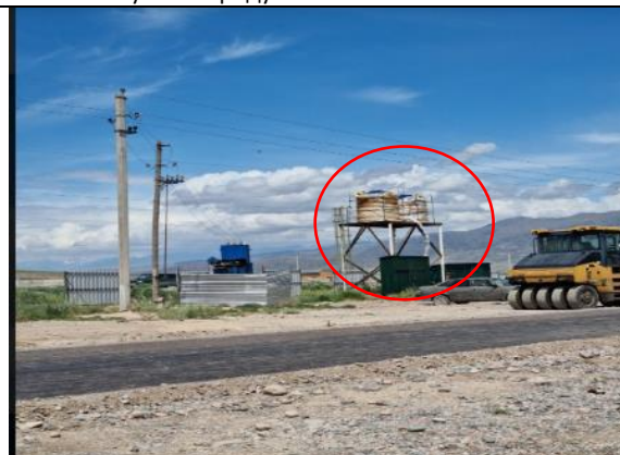
Фото 50. Электрические подключения и резервуары бытового водоснабжения (встроенный).
