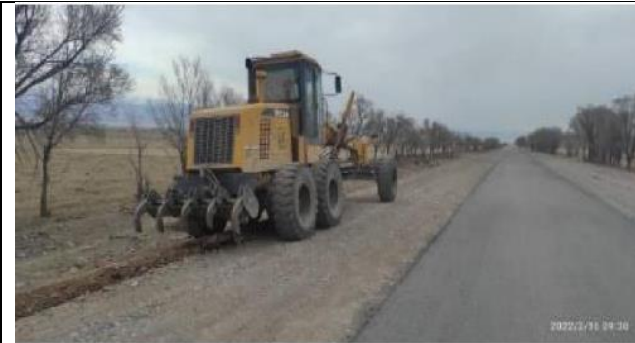
Фото 15. Подрезание обочины дороги км 71 - км 79.
