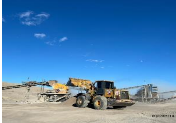
Фото 52. КДУ в работе Лот 2.
