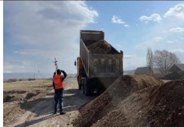
Фото 20. Обратная засыпка земляного полотна км 88+660 - км 88+740.
