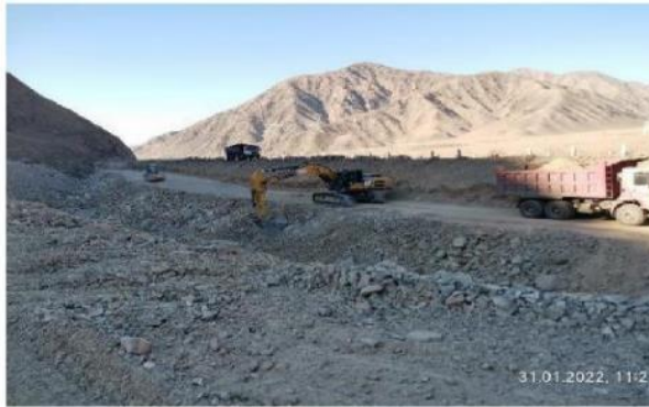
Фото 5. Отсыпка насыпи на км41+940.
