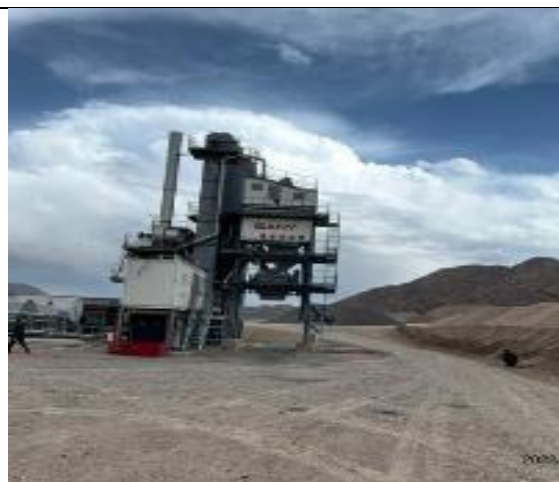
Фото 60. Работающий АБЗ Лот 1. Надлежащее содержание объекта и территории.
