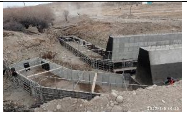
Фото 28. Установка опалубки подпорной стенки моста через р. Ак-Учук км 86+261.
