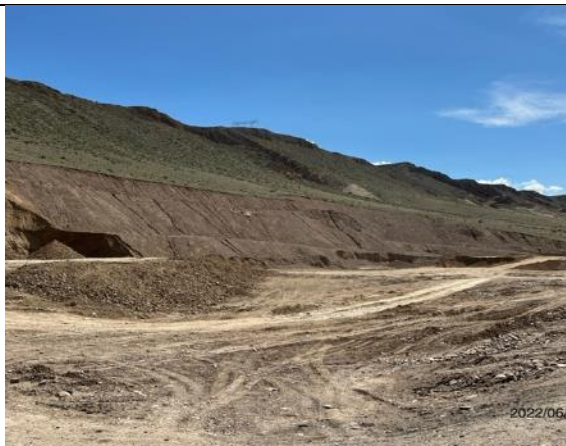
Фото 69. Методика разработки карьера была изменена для предотвращения эрозии и обеспечения безопасности.
