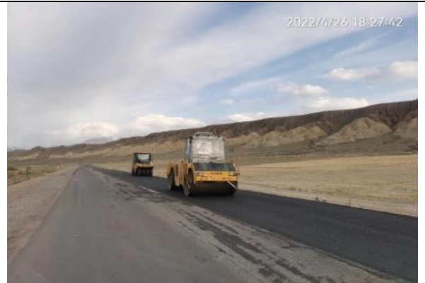
Фото 24. Укладка биндер слоя км 74+120 - 75+00.
