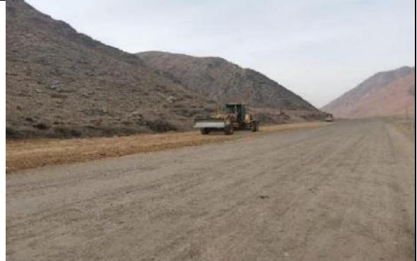
Фото 6. Уплотнение насыпи на Км12+860 - Км13+000.
