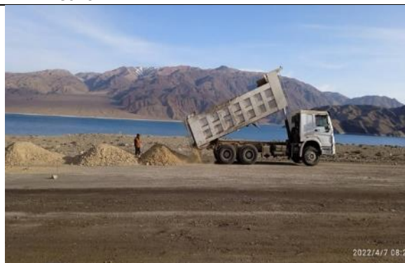
Фото 4. Обратная засыпка на км33+200-км33+700 LS.
