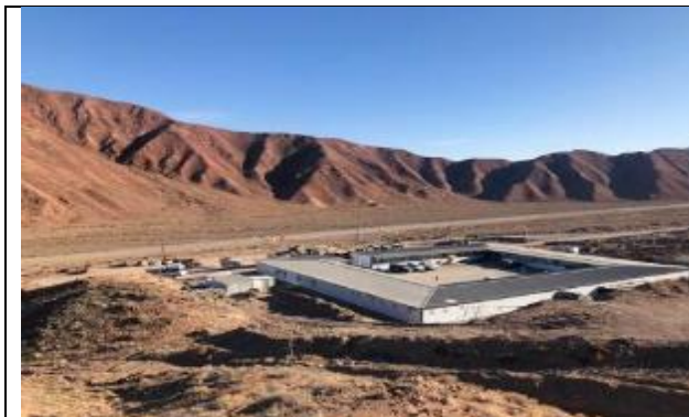
Фото 29. Общий вид лагеря Лот 1 км 16 + 100 (RS).
