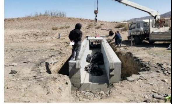
Фото 8. Установка ЖБТ на км 11+543.
